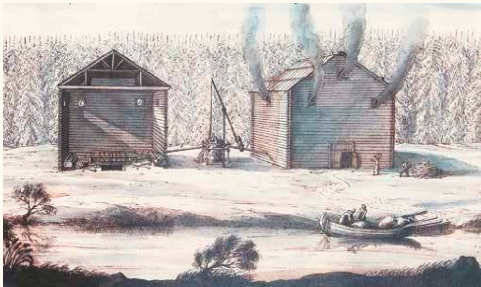
Солеварня. Старинная гравюра. Кроме самих варниц (двух больших изб, покрытых двускатными крышами) на рисунке показан соляной колодец с журавлём (особая разновидность подъёмного механизма), находящийся между ними.
